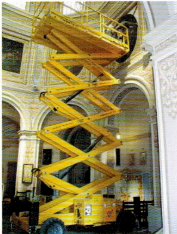
Plataforma elevadora empleada para tener acceso a las obras.
